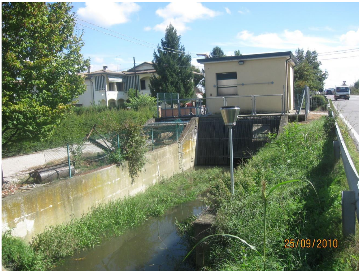
Figura 23. Impianto idrovoro Salvi
