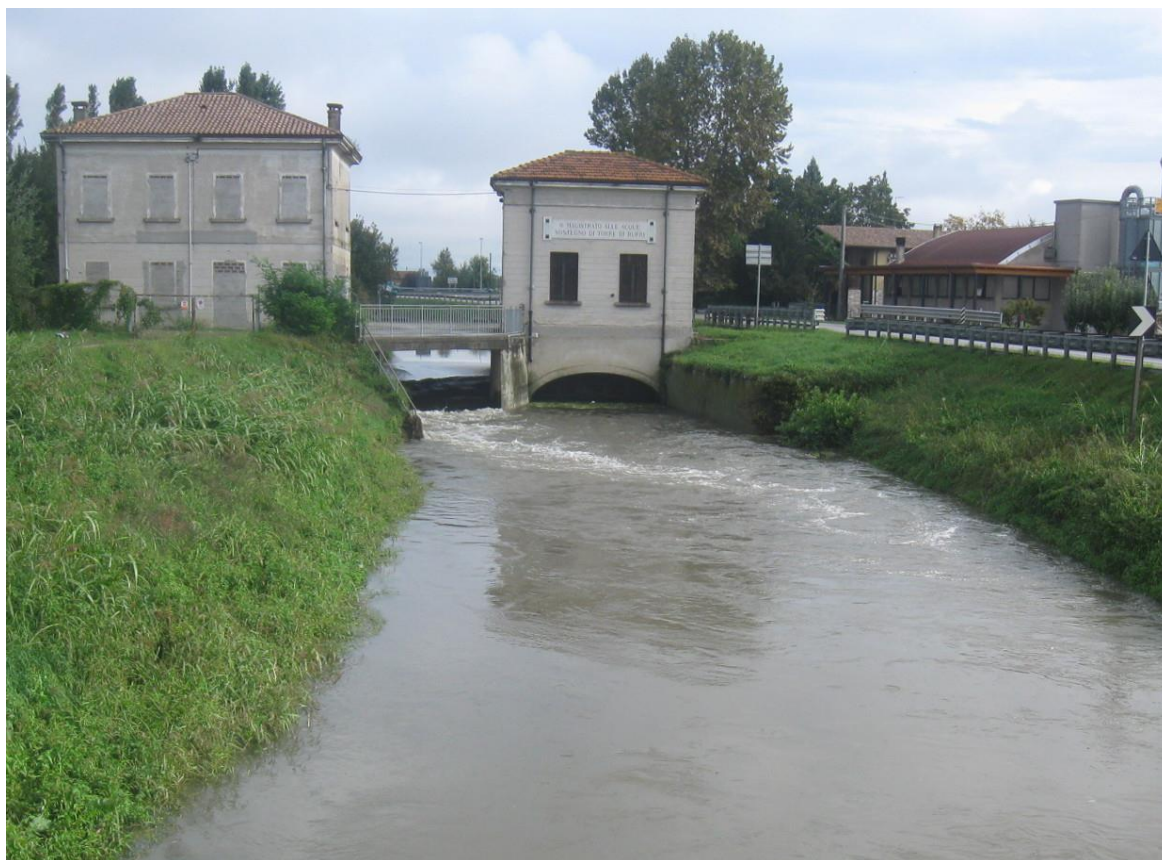
Figura 15. Manufatto di sostegno di Torre dei Burri
