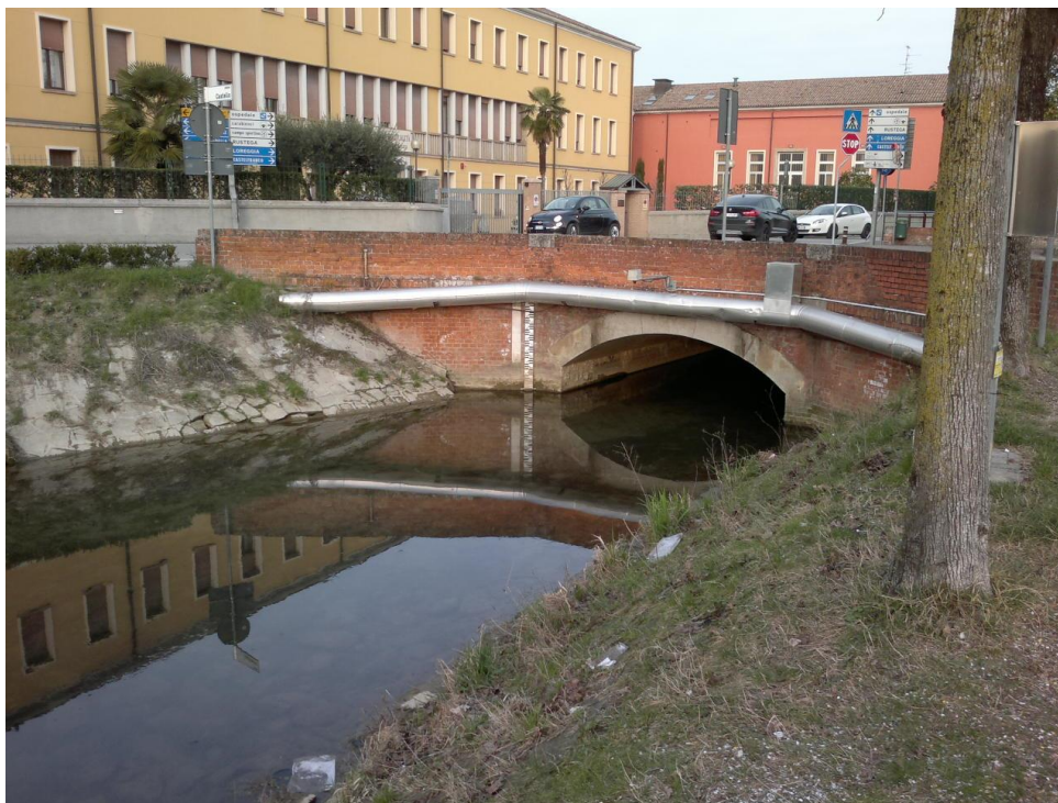
Figura 26. Misuratore di livello sul Vandura a Camposampiero
