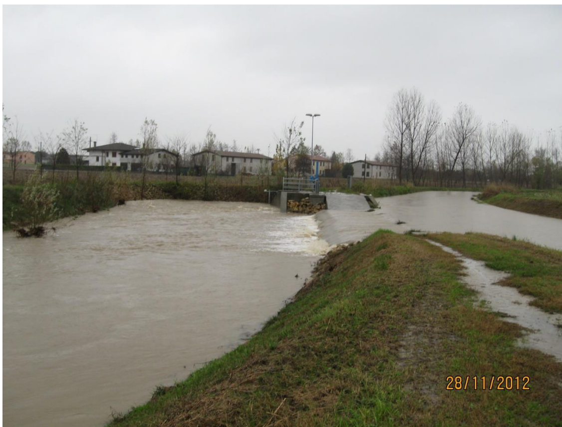
Figura 19. Manufatto scolmatore del Tergola in Piovego di Villabozza
