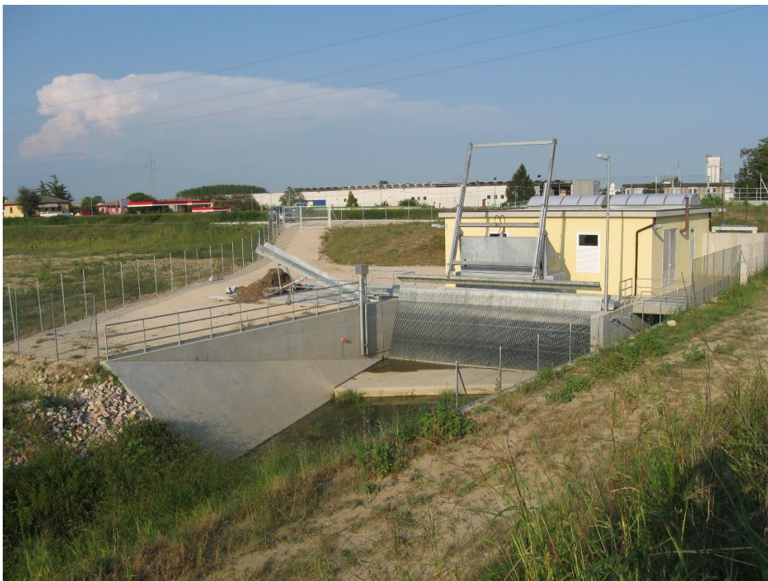
Figura 25. Impianto idrovoro Agugiaro
