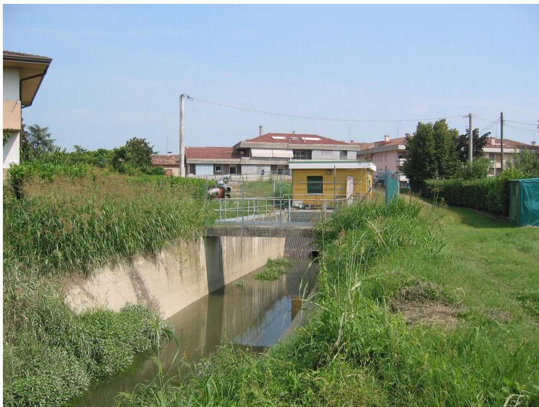
Figura 24. Impianto idrovoro Moretta
